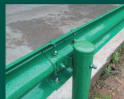
两波护栏连接图
