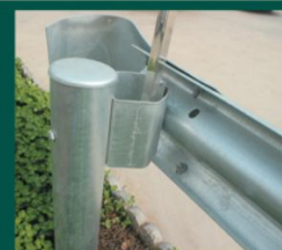
两波护栏连接图
