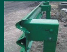
喷塑三波护栏连接图
