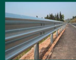
三波护栏配圆柱连接图
